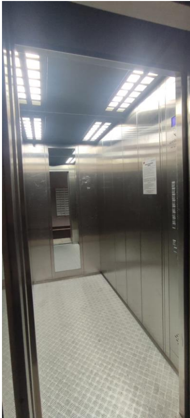
Замена светильников в шести лифтах 1 и 2 парадной
