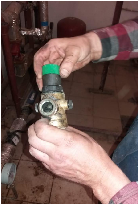
Замена оборудования в ИТП.
