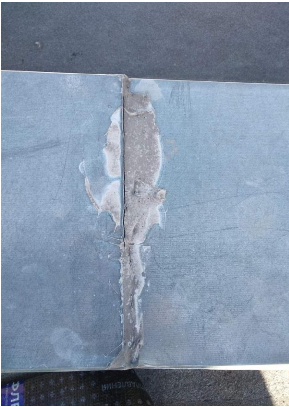
Загерметизированы стыки парапетов по периметру всей крыши
