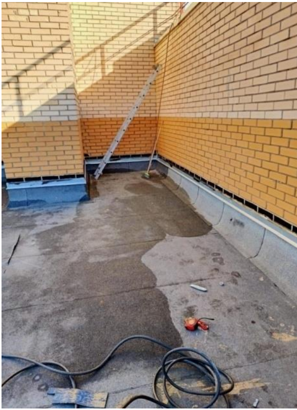
Произведена замена кровельного покрытия
