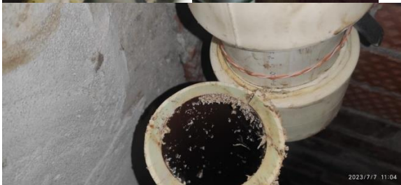
Ремонт подъемного стояка ГВС 5 парадной
