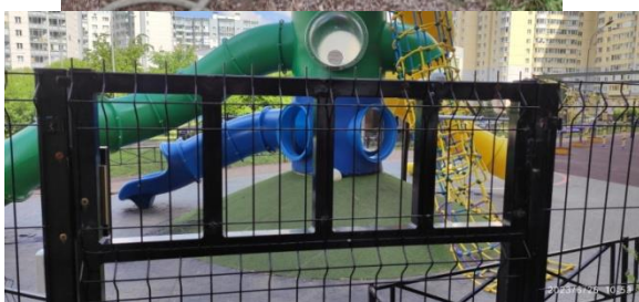
Произвели ремонт ограждений и электромагнитных замков на калитках
