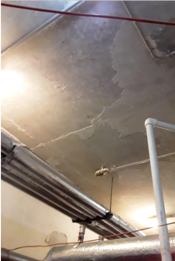
Ремонт всех ИТП. Обрушающаяся штукатурка падала на приборы.
