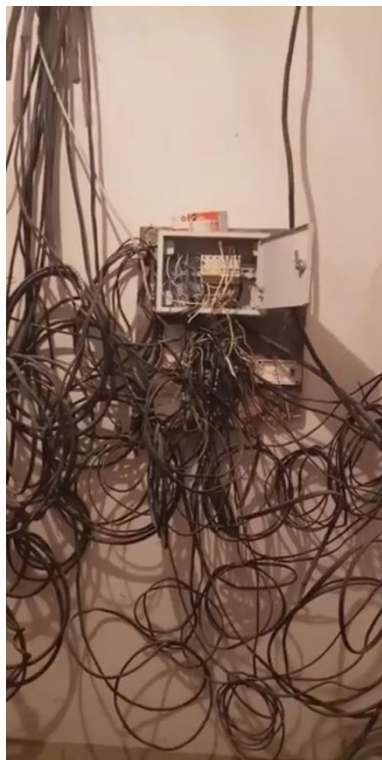
Установлены счетчики в ГРЩ №3.
