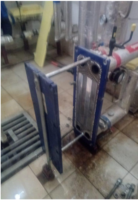
Ежегодная промывка теплообменников
