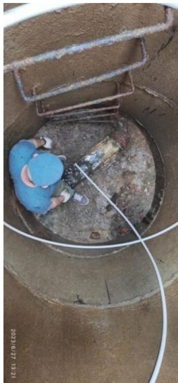
Устранение засора внешних сетей канализации 1-3 парадных
