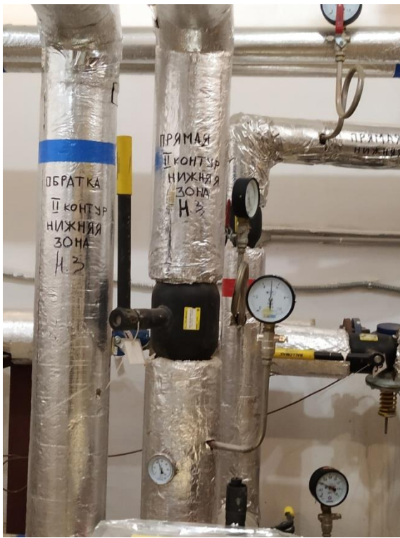
Нанесена маркировка на все стояки и трубы
