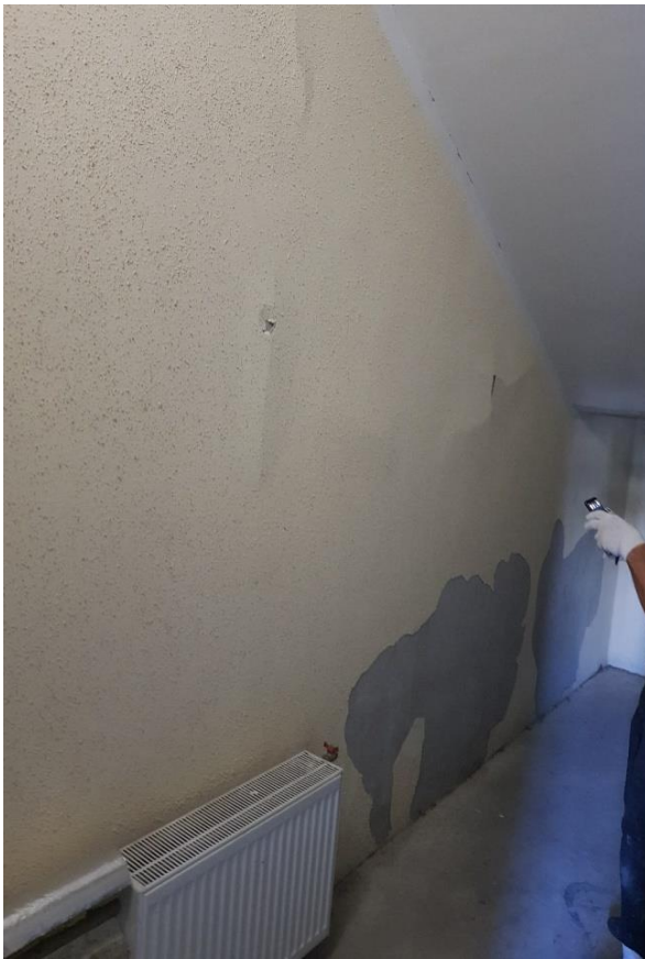
Отремонтированы 1-3 этажи черных лестниц во всех парадных
