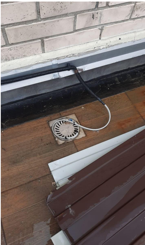
Обустройство подогрева воронки на террасе 1 парадной
