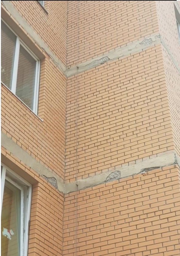
Восстанавливается герметизация межпанельных швов
