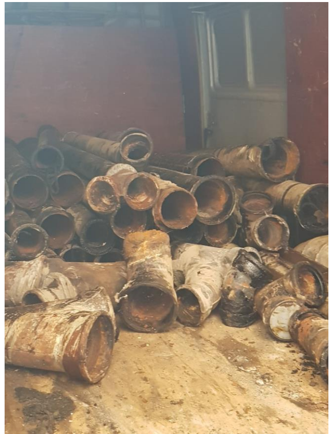
Завершены работы по замене всех канализационных лежаков по всему подвалу
