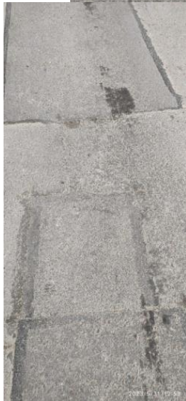
Произведен ремонт асфальтного покрытия дворового проезда
